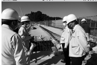
国道293号東バイパス橋梁
