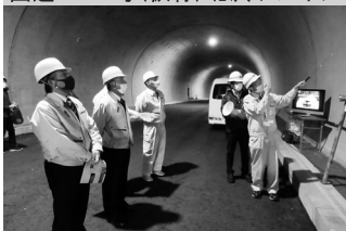
国道461号(仮称)北沢トンネル
