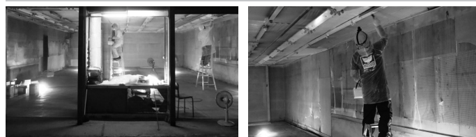
「リビングルーム鯨ヶ丘」会場となる空き店舗の改修作業
