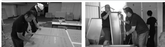
「Signs of Memory」ピンクの窓製作及び設置作業
