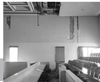
損壊した議場内
